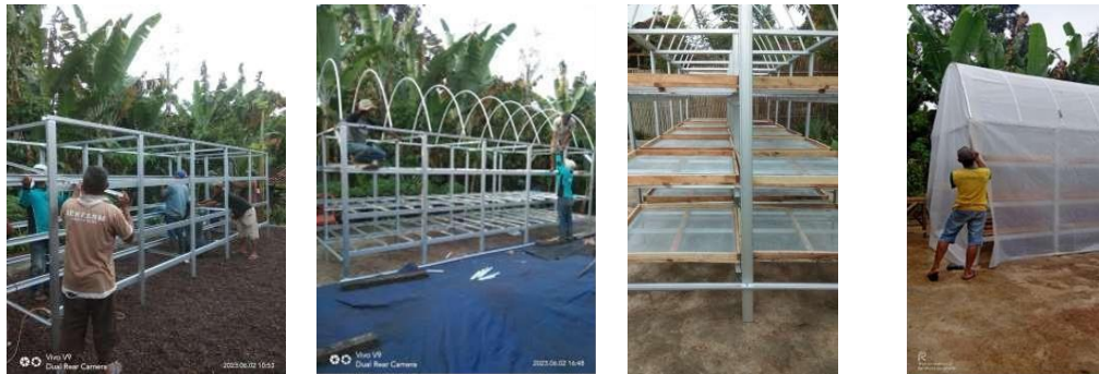
Gambar 3. Pembuatan alat pengering energy matahari ( solar dryer ) tipe rak bersusun oleh kelompok tani mitra kegiatan
